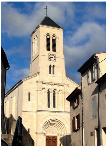
L'église après les travaux
