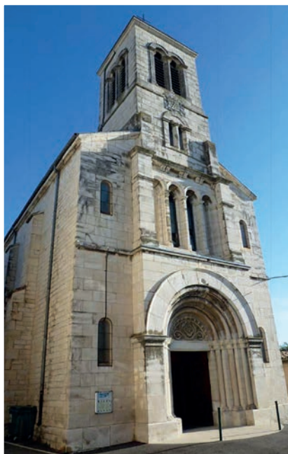
L'église avant les travaux
